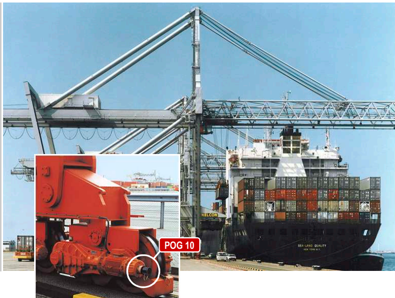
Container gantry Containerkran
